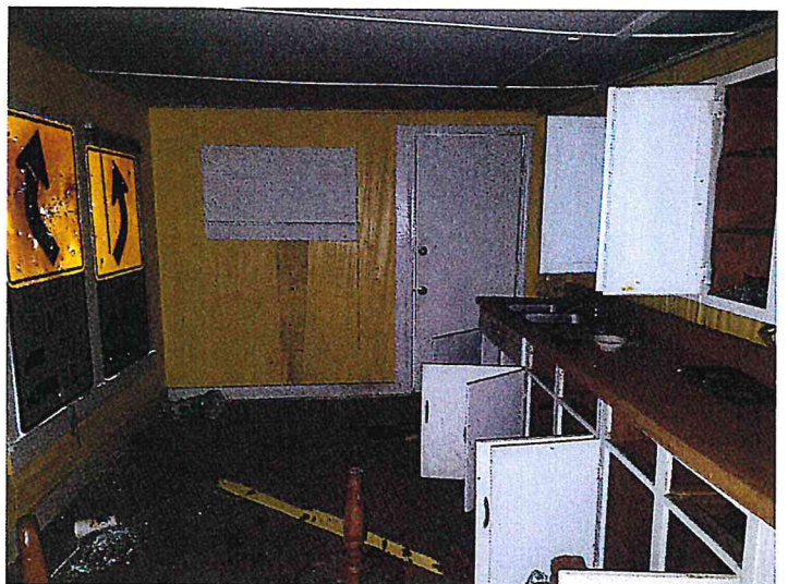
4/19/2016 513 C - INTERIOR Pic (25).jpg
