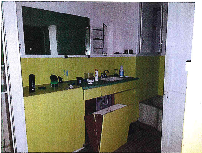
4/19/2016 513 C - INTERIOR Pic (24).jpg
