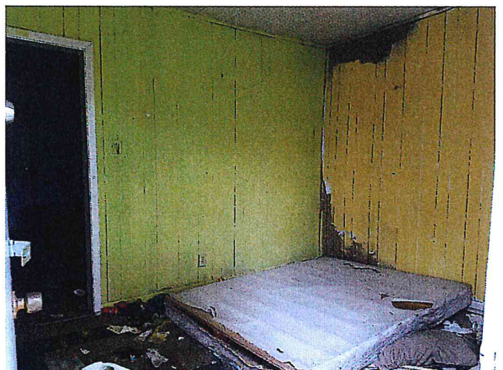
4/19/2016 513 C - INTERIOR Pic (21).jpg
